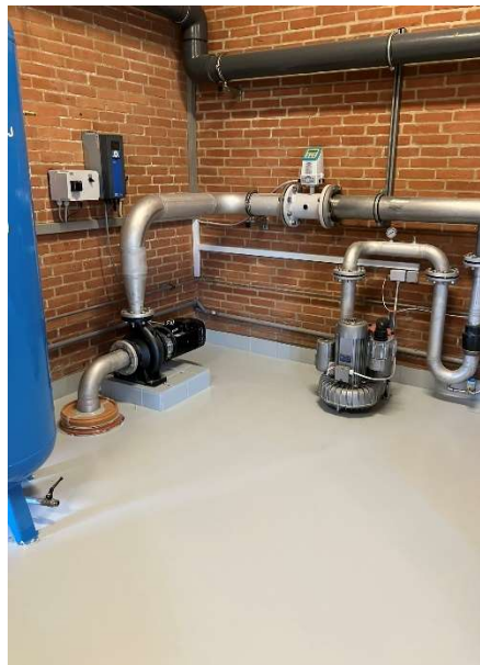
Skyllepumpe og kapselblæser
