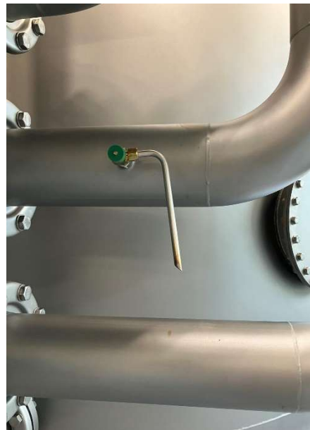
Prøvetagningsshane – mulighed for prøvetagning efter hvert filter
