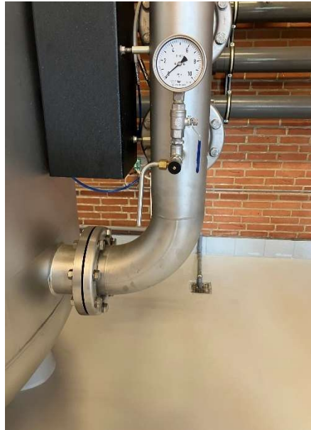
Prøvetagningshane – mulighed for prøvetagning efter hvert filter
