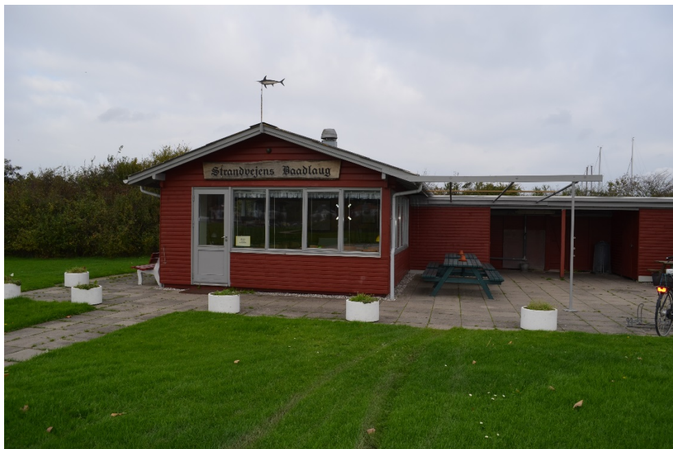
Figur 13 Strandvejens bådlaug har en klubhusbygning i området tæt ved kysten.
