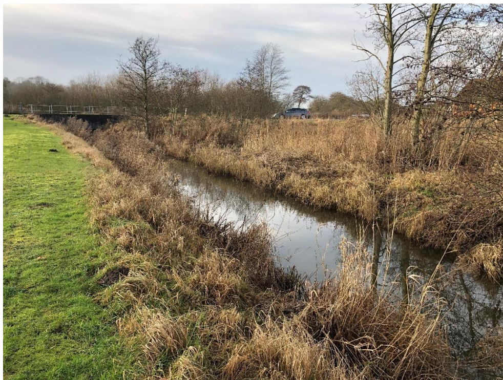
Figur 5-3 Eksisterende sandfang umiddelbart nedstrøms broen over Egå.
