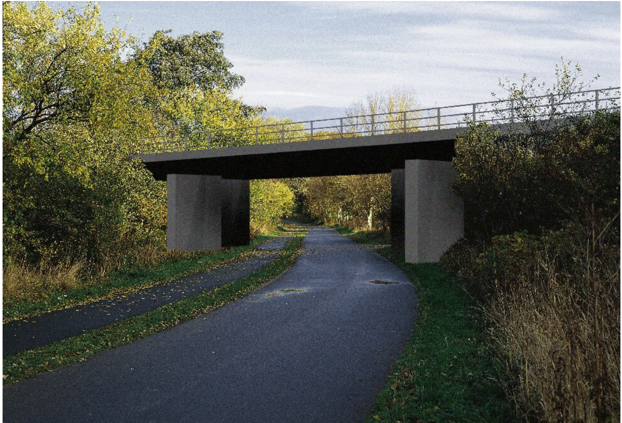
Figur 5: Visualisering af godstogs-shunt ved passagen af den sydlige gren af Brabrandstien (Konstruktion med pladeformede bropiller)
