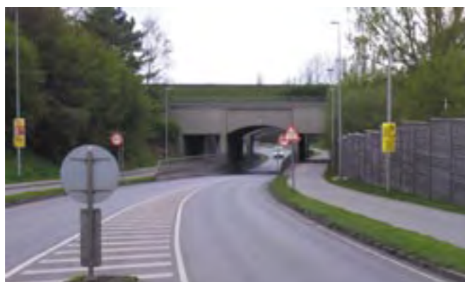
Den eksisterende jernbanebro ved Langenæs - set mod øst
