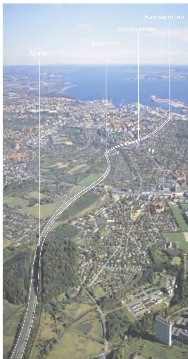
Vejen løber langt ind i den landskabelige kile, og tegner derved den kortest mulige rute igennem den tætte by
