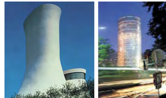
Reference - skorstene til tunnelventilation
