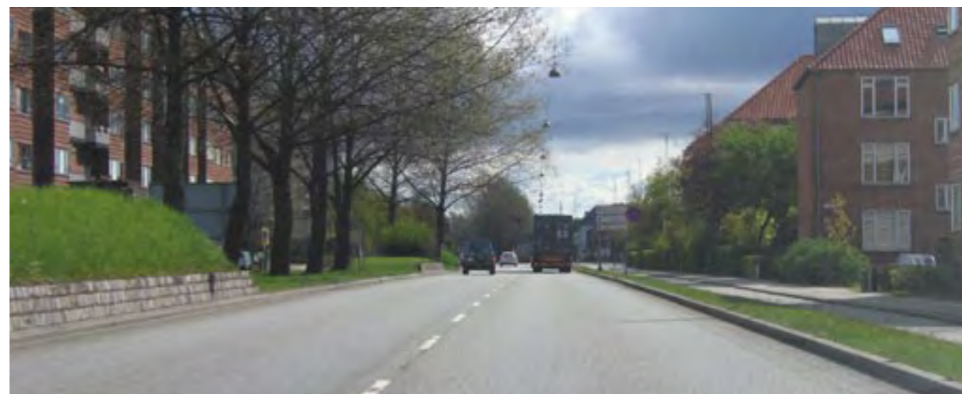
Foto - eksisterende forhold
