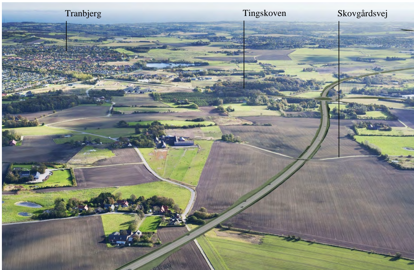
Figur 65 Luftvisualisering af passagen syd for Tranbjerg og Tingskoven (i baggrunden) Vejen ligger primært i afgravning frem til rundkørslen. Stioverføring ved Skovgårdsvej. Luftvisualisering 8.
