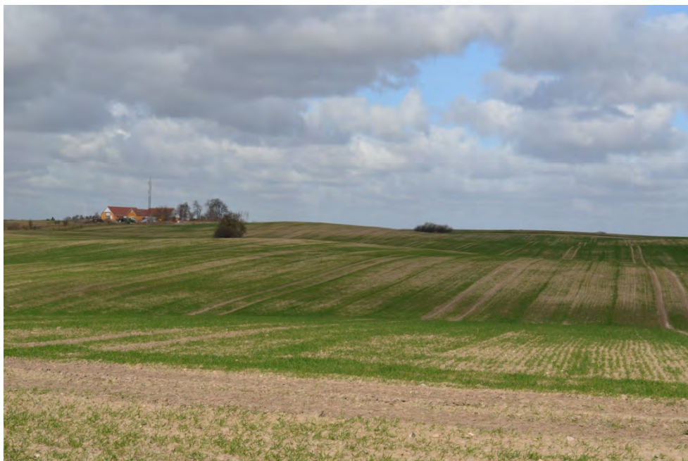
Figur 55 Typisk landskab mellem Ensted og Landevejen. Vejen vil med sit forløb på flere meter høje dæmninger eller i tilsvarende afgravning udgøre et markant brud med det eksisterende landskabs former idet den ikke følger landskabets varierede rytme og kuperede terræn.
