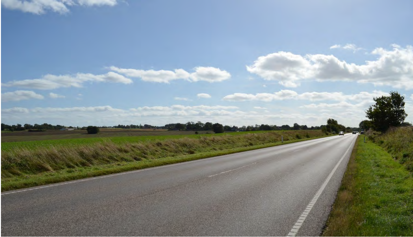
Figur 74 Landevejen set mod syd. Eksisterende forhold.
