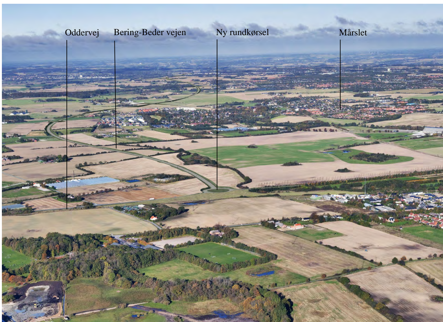
Figur 36 Bering-Bedervejens tilslutning til Oddervej er fælles for de 3 alternativer, her vist for alternativ A. Luftvisualisering 4.
