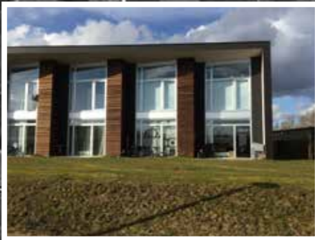
Petersminde, Åbyhøj AL2bolig Arkitekt: Prisme Arkitekter Indflyttet: 2009
