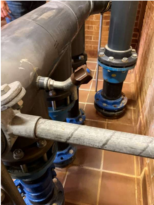
Prøvehane – råvand indgang vv
