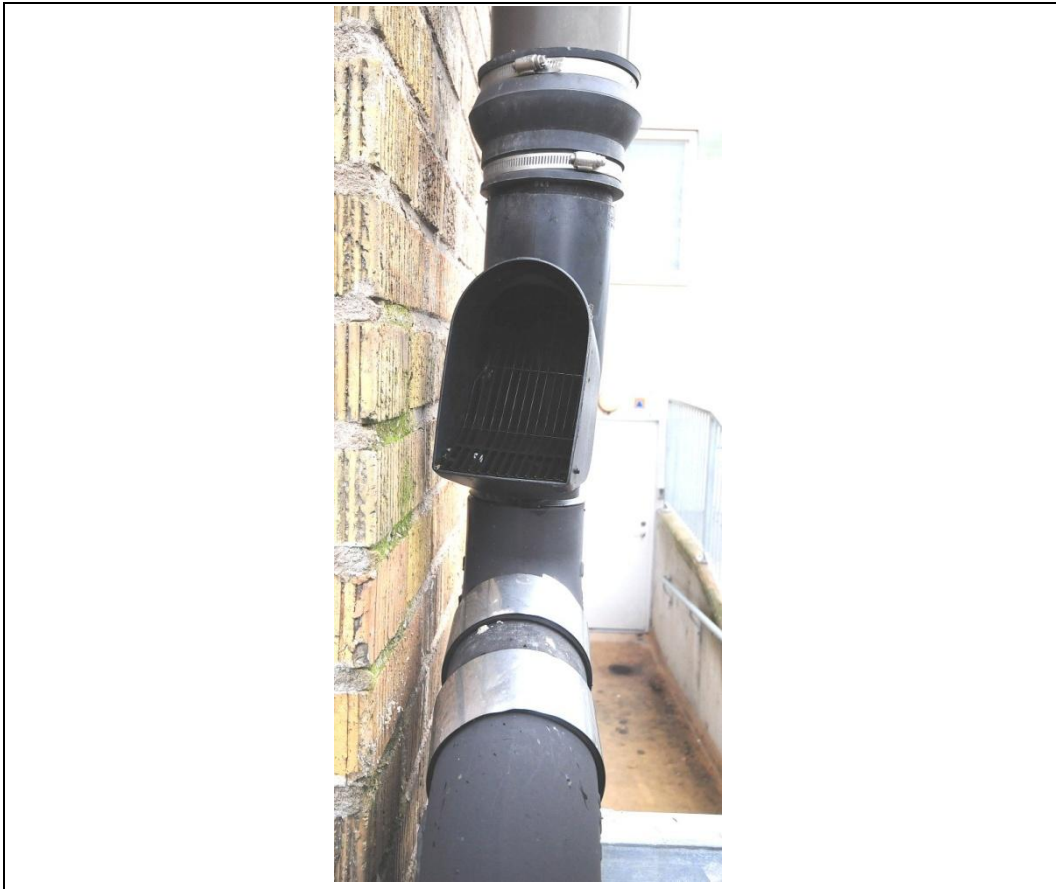
Figur 3.1 Grovfilter på tagedløb (Foto: Kaj Vestergaard).
