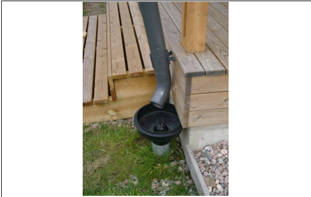
Figur 2.1 Bladfang ved tagnedløbsrør.
