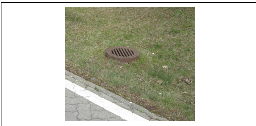
Figur 3.2 Eksempel på vejbrønd i græsribat.
