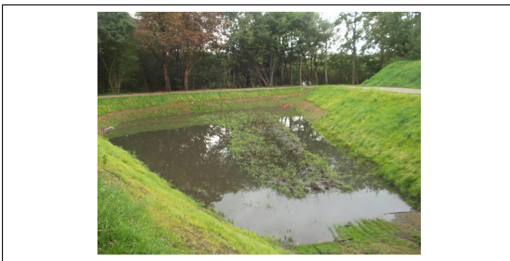
Figur 1.1 Eksempel på et åbent sandfang.
