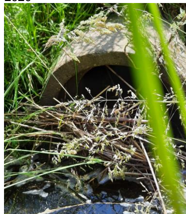
Foto 4. Rørunderføring ved st. 205 m, foto er taget d. 25. juni 2020
