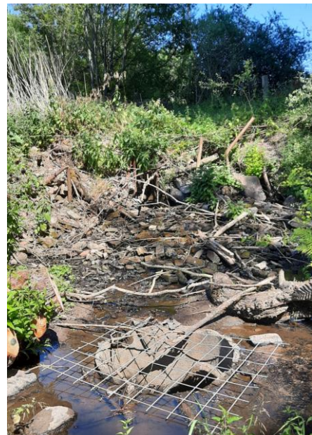
Foto 8. Udløb fra søen og rørbrønd ved st. 368 m, foto er taget d. 25. juni 2020.
