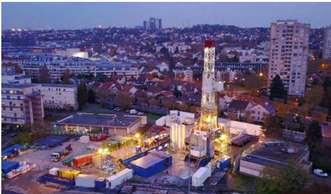
Foto 4 Geotermisk boring i Cachan i Frankrig 2017. Byen har udnyttet geotermisk energi siden midten af 80'erne. Det nye brøndpar skal erstatte to gamle brøndpar og levere varmt vand og varme til hvad der svarer til 7.000 husholdninger (offentlige bygninger, erhverv og lejligheder) (Le Parisien, 2017).
