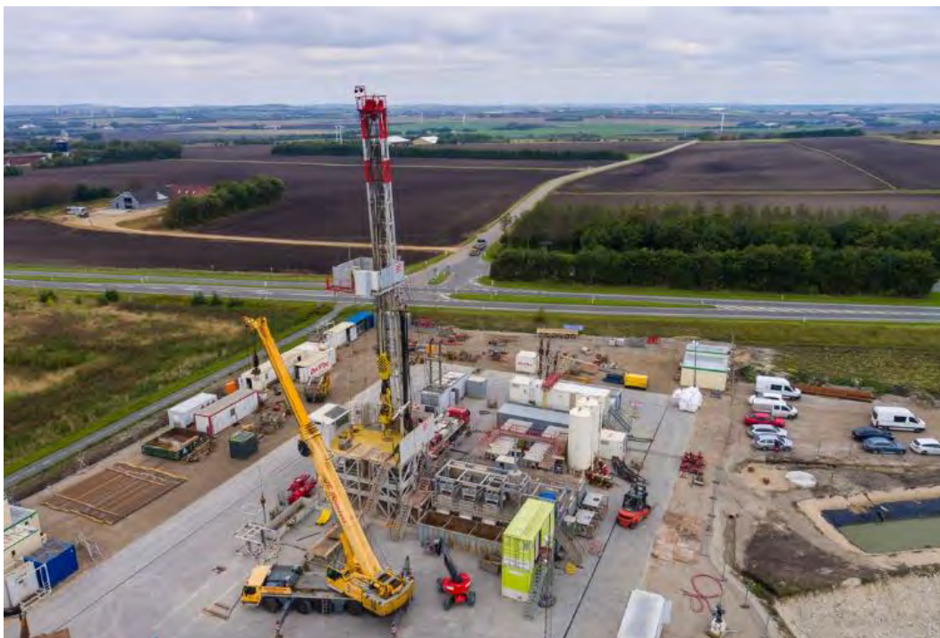
Foto 2 En borerig sættes op (boring af Injektions brønd i Thisted 2017, Thisted Varmeforsyning, 2019). Se også timelapse film på ca. 5 minutters varighed af boringen på https://www.thisted-varmeforsyning.dk/geotermi/
