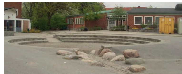
PLADS - UDFØRT I SÆNKET NIVEAU OG ANVENDT TIL REGNVAND UNDER KRAFTIGT NEDBØR
