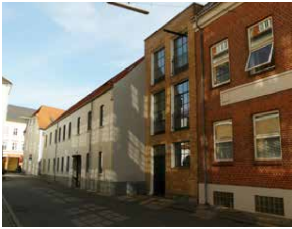
RENOVERING I GADEFORLØB
