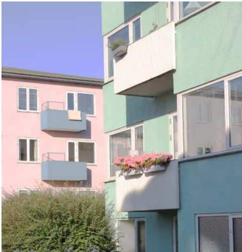
Foto: Standparken - Arkitekt Alfred Mogensen.
