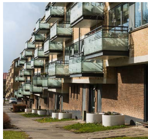
Foto: Afskærmning på terræn under lavt siddende altaner.
