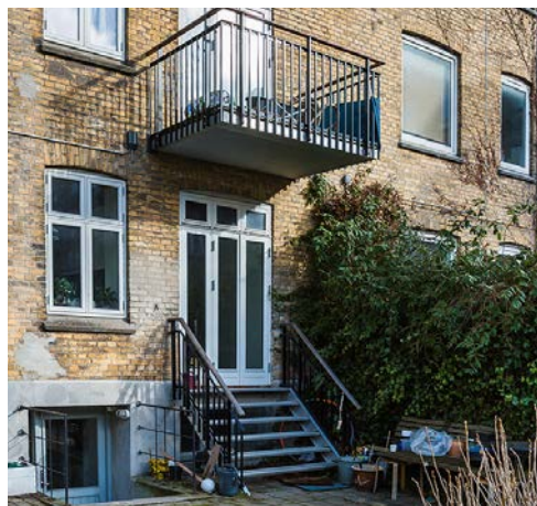
Foto: Udgang til gård fra stueejlighed. Trappen muliggør kældervindue bibeholdes intakt.
