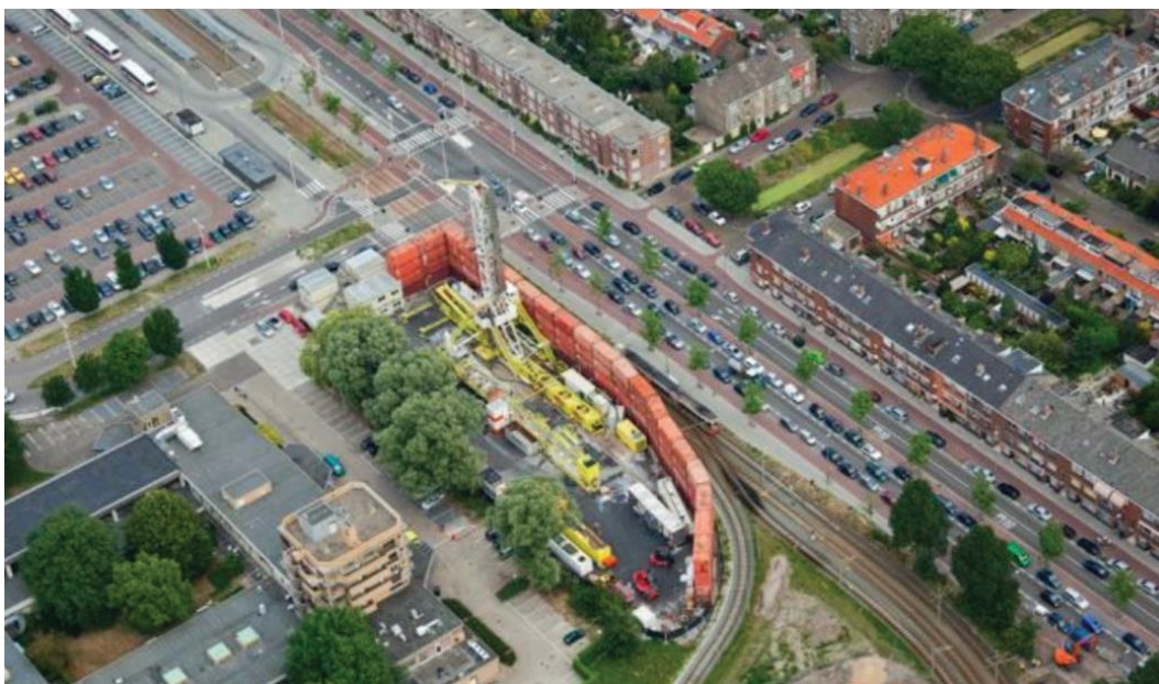
Foto 3 En geotermisk boring i bymæssig bebyggelse i Holland: LOC 400 borerig fra Huisman på boreplads i Den Hague, Holland (Huisman, 2019), se biler for skala. Der skal bruges ca. 50x100 meter til boreplads. Boringen tager ca. 30-40 dage, hvorefter pladsen afvikles, og det tekniske anlæg fylder, hvad der svarer til et straffesparksfelt på en fodboldbane (500-600m 2 ). Der skal være gode tilkørselsforhold til pladsen, også efter boringen er afsluttet, så man kan komme til anlægget og lave løbende vedligehold.
