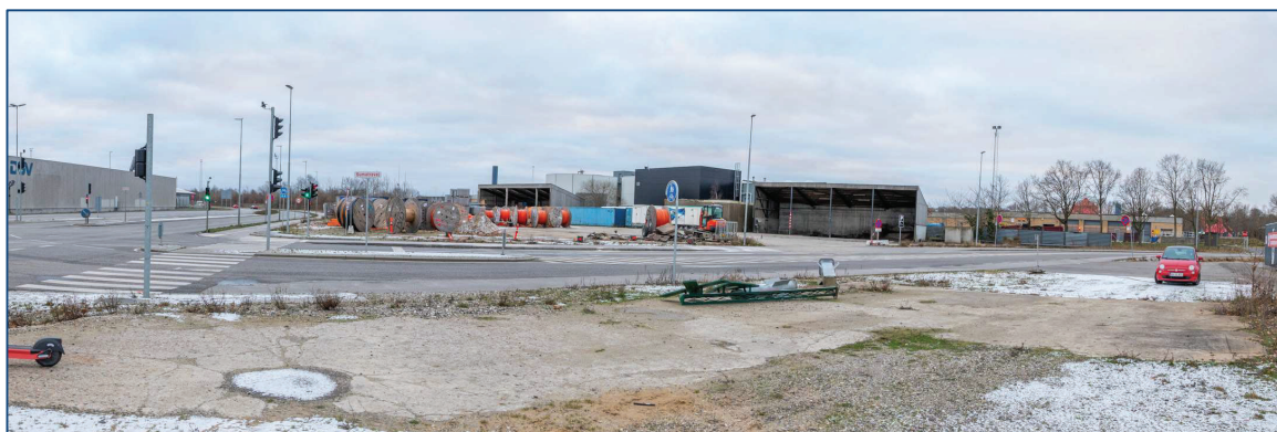
Figur 2: Øverst: Matrikel 2148fi, 2148fk og 2148aq med kontor- og lagerbygninger set fra matrikel 2148ci med Sumatravej i forgrunden. Nederst: Matrikel 2148c med lagerbygninger og opmagasineringsplads. Sumatravej ses i forgrunden og Østhavsvej til venstre.
