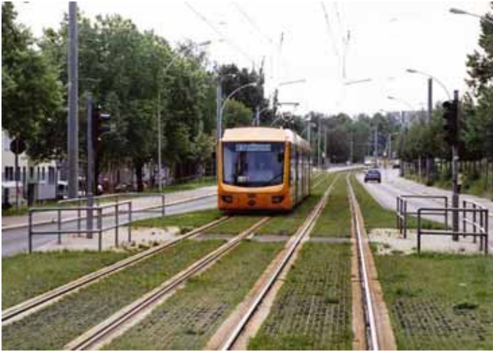
Figur 3-17 Embedded spor med indlagte græskassetter (Chemnitz, Tyskland).
