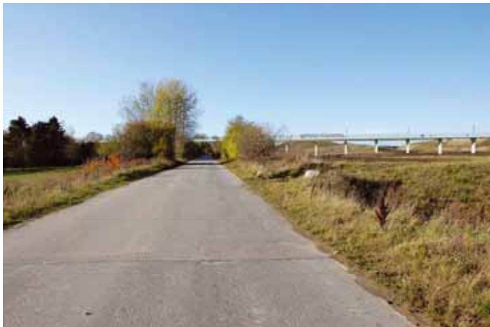
Figur 8-45 Visualisering af hovedforslagets variant 1, fuld brosløsning, ved krydsningen af Gl. Søftenvej (T12).
