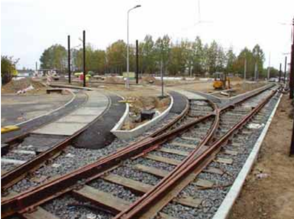
Figur 3-15 Normalt ballasteret spor med overgang til belagt ballasteret spor (Rostock, Tyskland).
