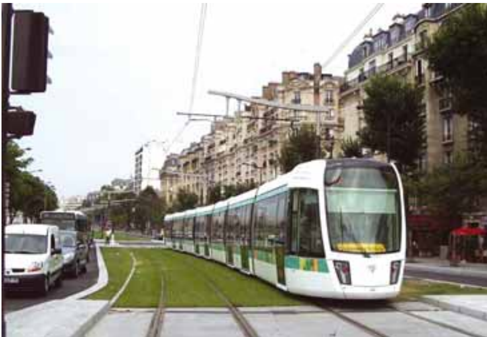
Figur 3-18 Embedded spor forstøbt på fabrik og færdiganlagt med rilleskinner faststøbt i en gummimasse. Desuden hulninger med græs (T3 i Paris).
