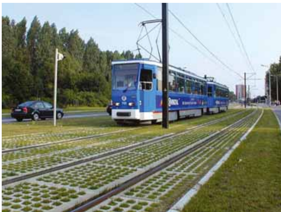
Figur 3-16 Ballasteret spor med græsarmeringssten, (Rostock Tyskland).
