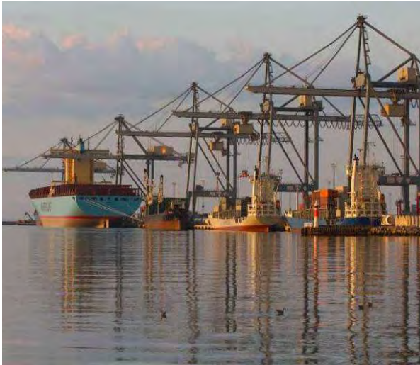
Kaj kraner (ZPMC kraner og Crone kraner)
