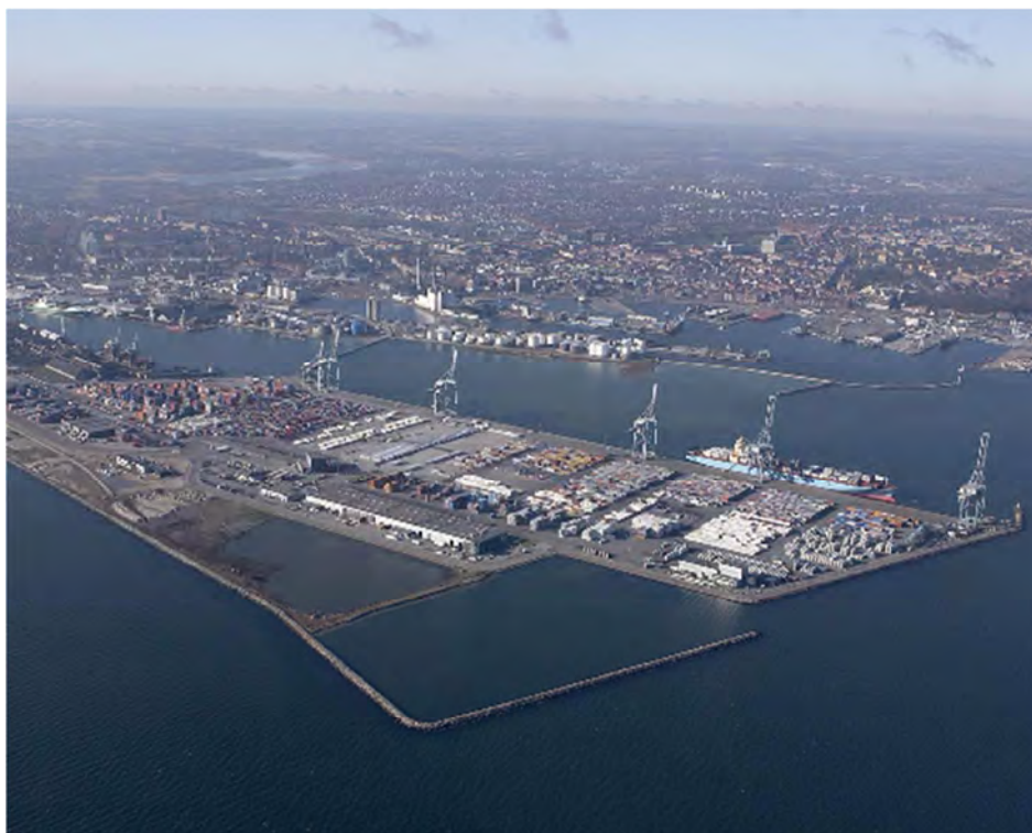
Figur 1.1 Foto af den eksisterende containerterminal på Østhavnen,
