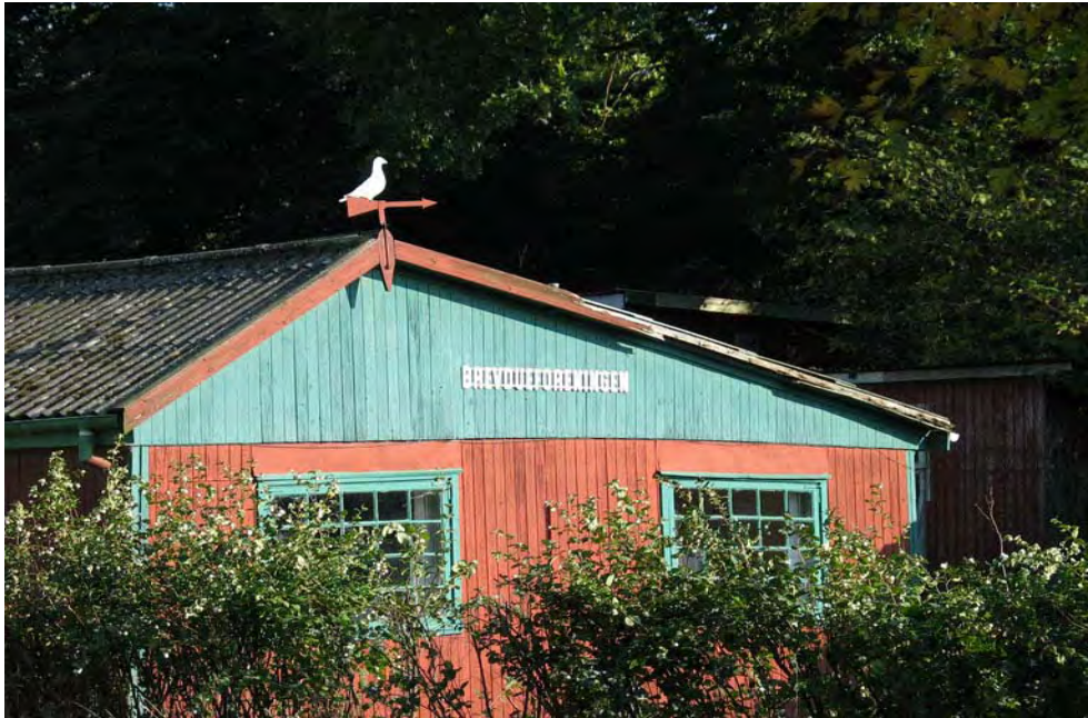
Figur 8.40 Brevduebanen ved Åhavevej.
