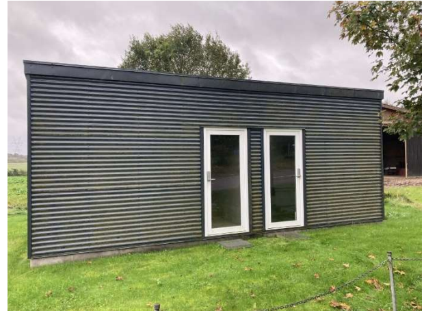
Bygning med pumper og rentvandsbeholder
