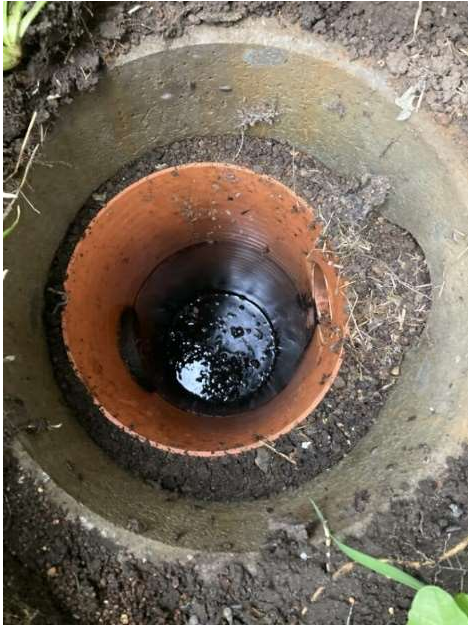
Brønd til filterskyllevand
