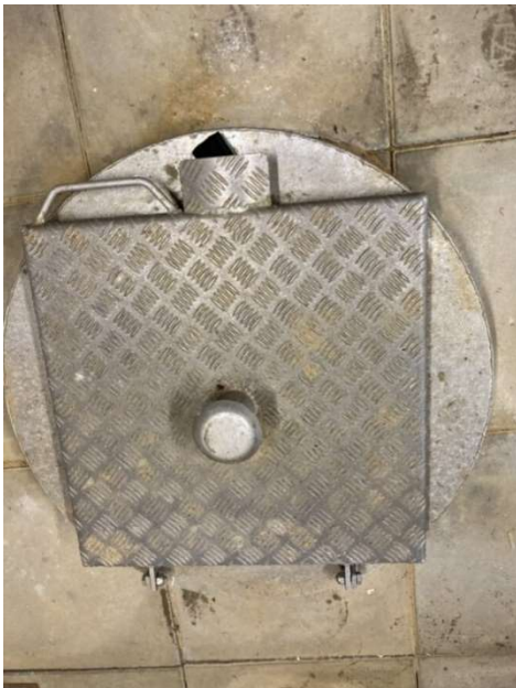
Brønd til filterskyllevand
