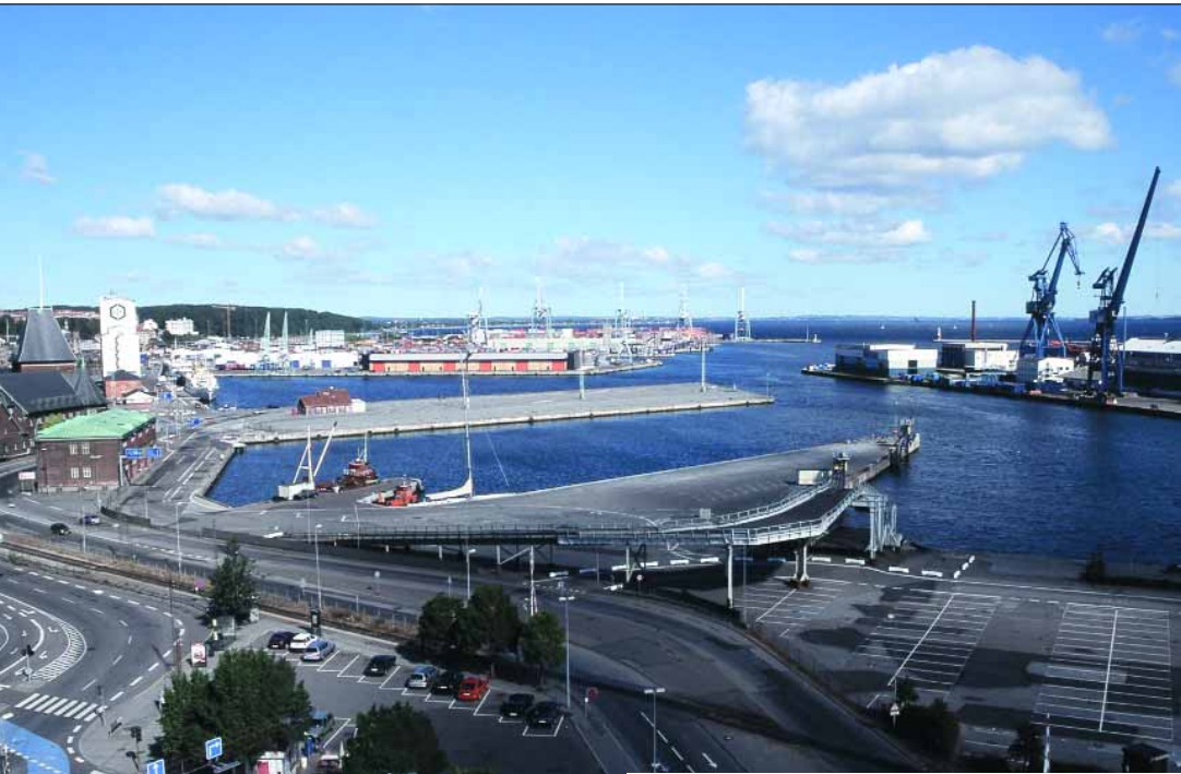
Hele havnebyrummet med de to indre havnebassiner beliggende nord og syd for Pier 1. I forgrunden den gamle Færgepier.
