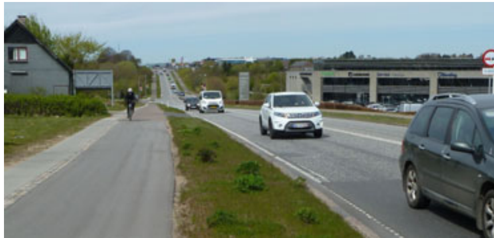
Figur 3.5 Indretning af Viborgvej med smalt fortov, cykelsti, skillerabat og kørebane vest for Runevej.
