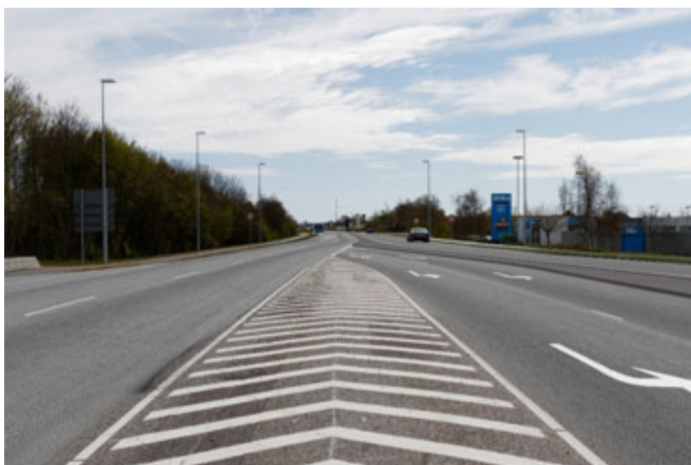
Figur 8.7 Udbygget Viborgvej med 1m bred befæstet midterhelle set mod øst ved Tilst Skolevej / Anelystvej. Nuværende udformning er vist i det øverste billede.
