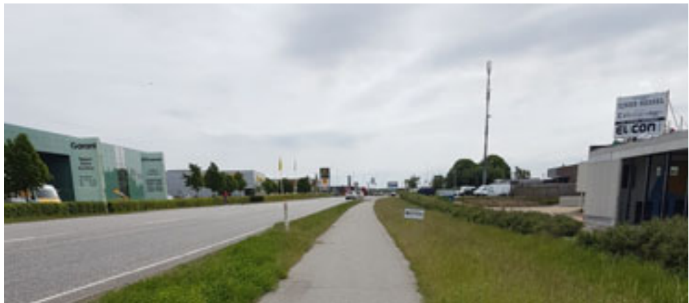
Figur 8.2 Viborgvej set mod øst mellem Tilst Skolevej og Holmstrupgårdvej
