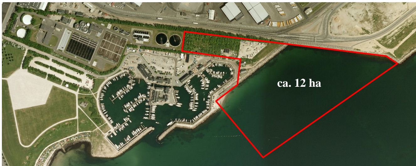
Figur 2 Areal, hvor det ny Marselisborg renseanlæg forventes etableret
