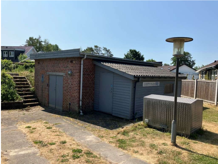
Gl. Hjortshøj Vandværk
