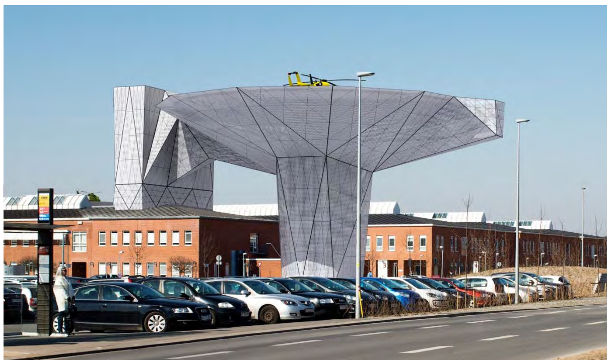
Figur 3-16. Principtegning af facadebeklædning på heliport H2 set fra syd. (mindre afvigelser i koter vil kunne forekomme ved senere detailprojektering).
