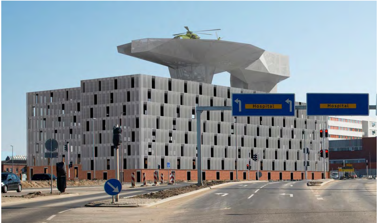
Figur 3-6. Principtegning af facadebeklædning på p-hus og heliport H1 set fra nord. (mindre afvigelser i koter vil kunne forekomme ved senere detailprojektering).
