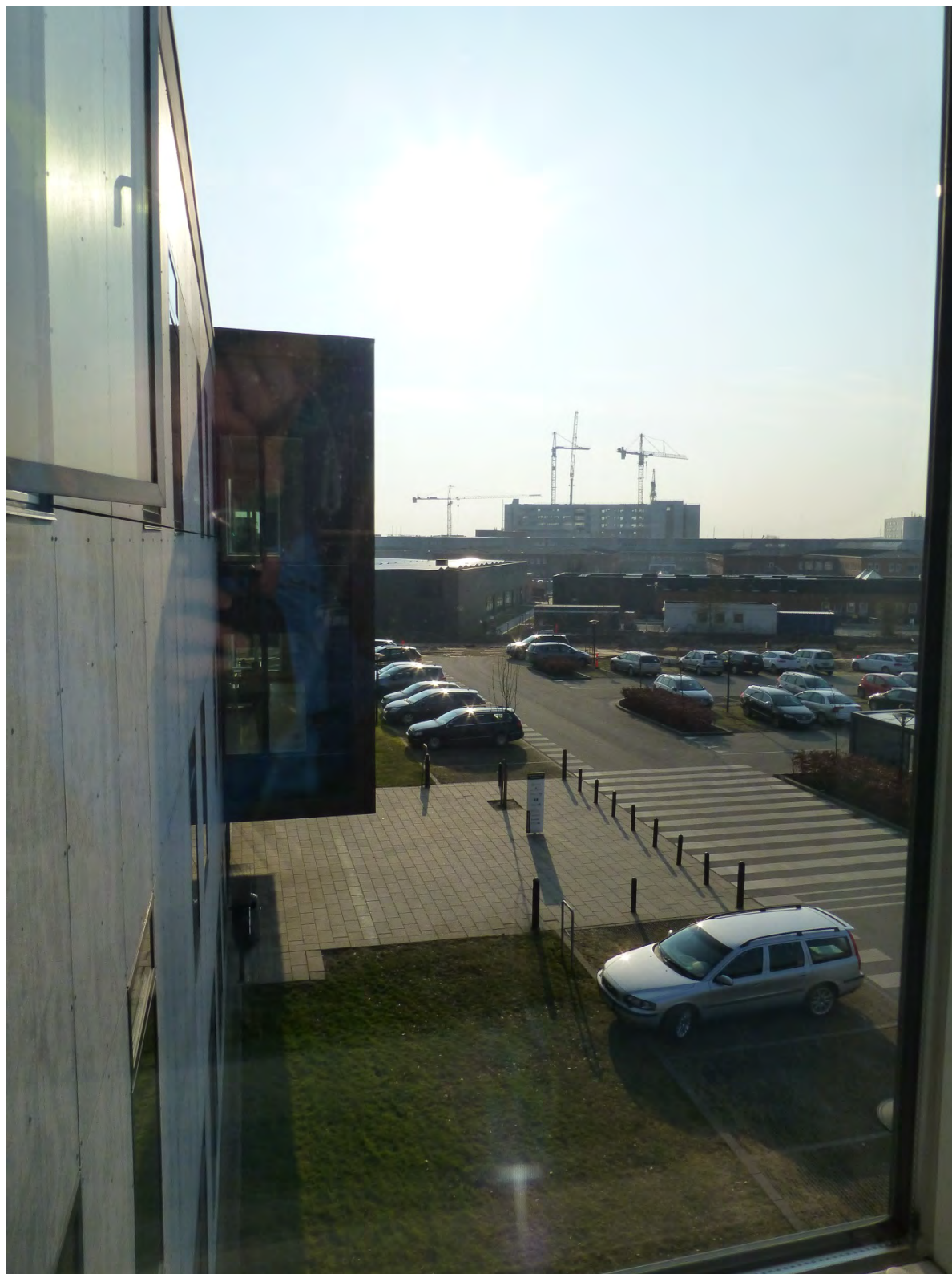
Figur 6-50. Bygning R1 ved Aarhus Universitetshospital (vist med solceller på taget) fotograferet fra en kontorbygning i 2. sals højde i en afstand på ca. 100 m d. 16-03-2015. Billedet er ikke beskåret.
