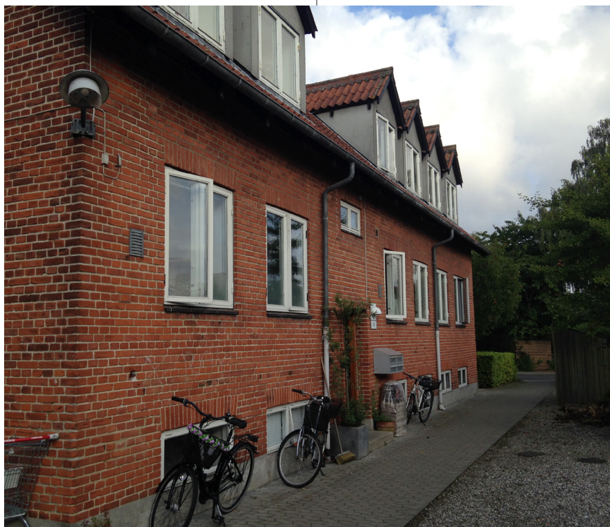
Dybbølvej før renoveringen
