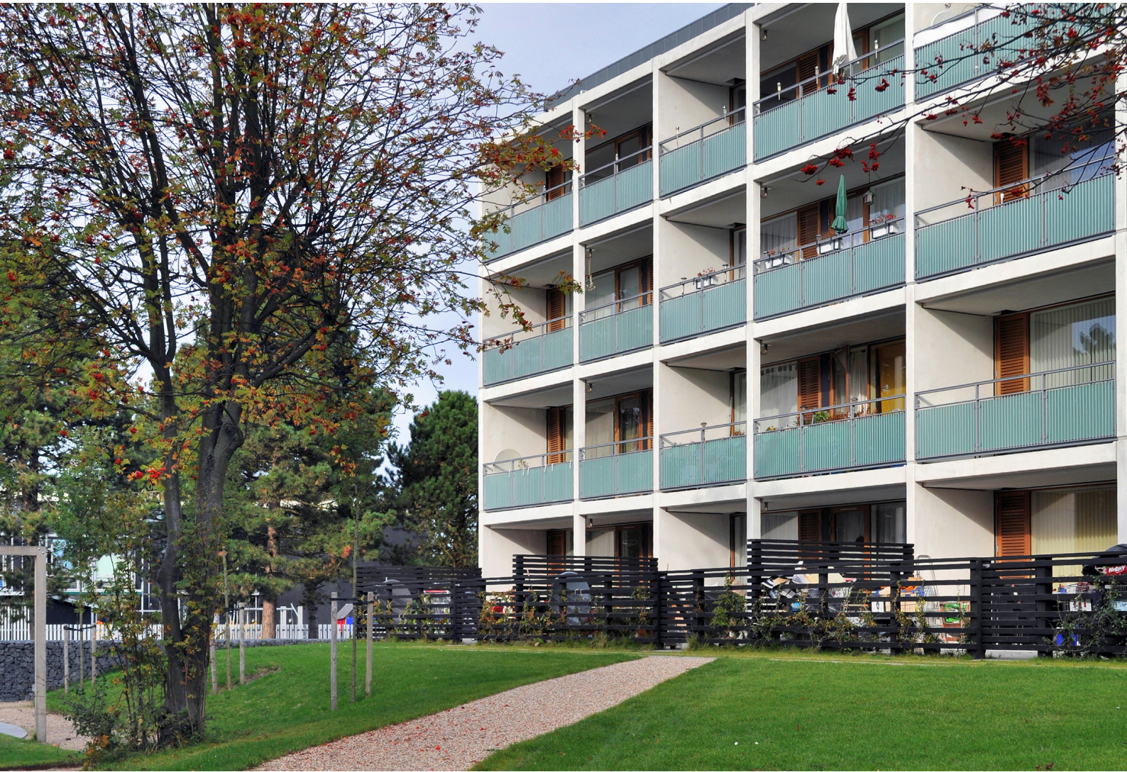
Gyldenrisparken efter renoveringen
