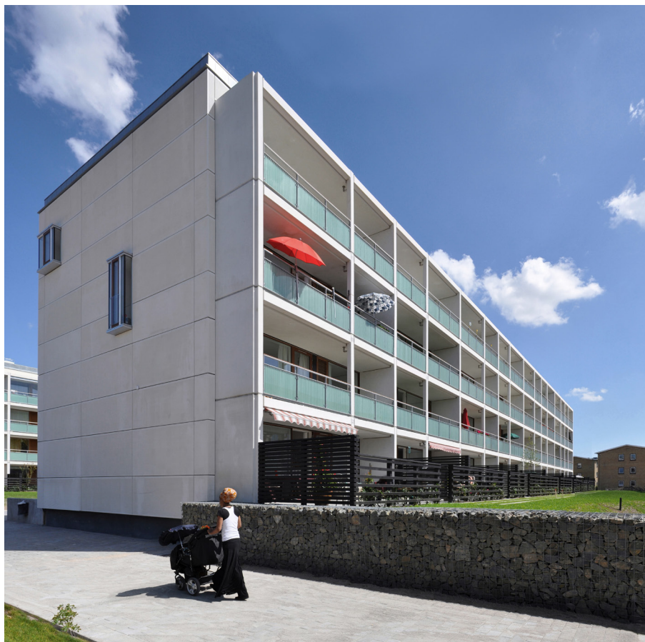
Gyldenrisparken efter renoveringen Foto: Seier
