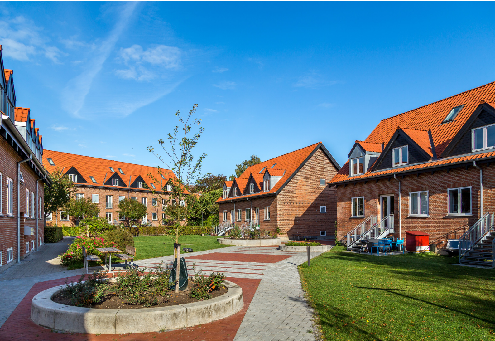
Dybbølvej efter renoveringen
