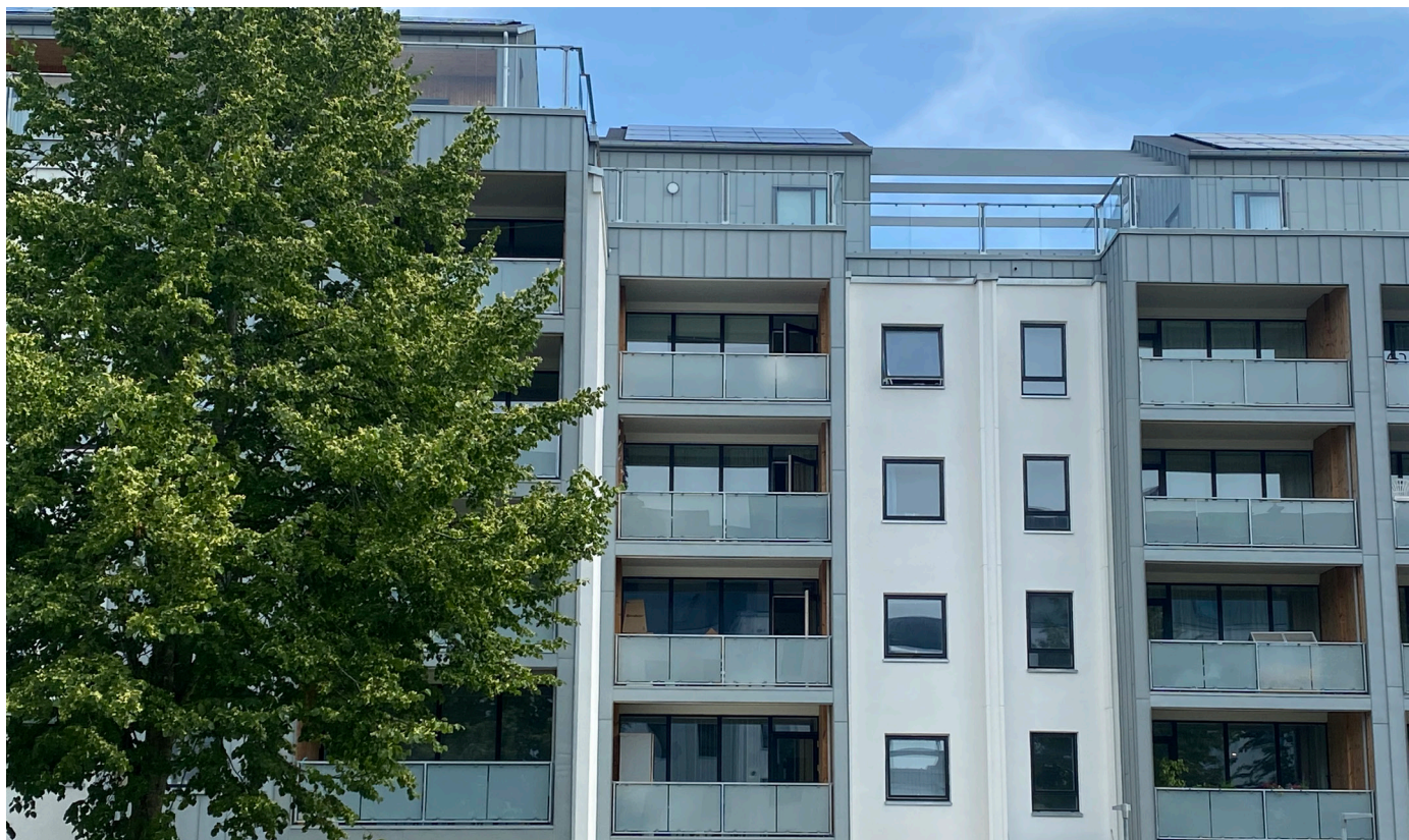
Rydevænget efter renoveringen
