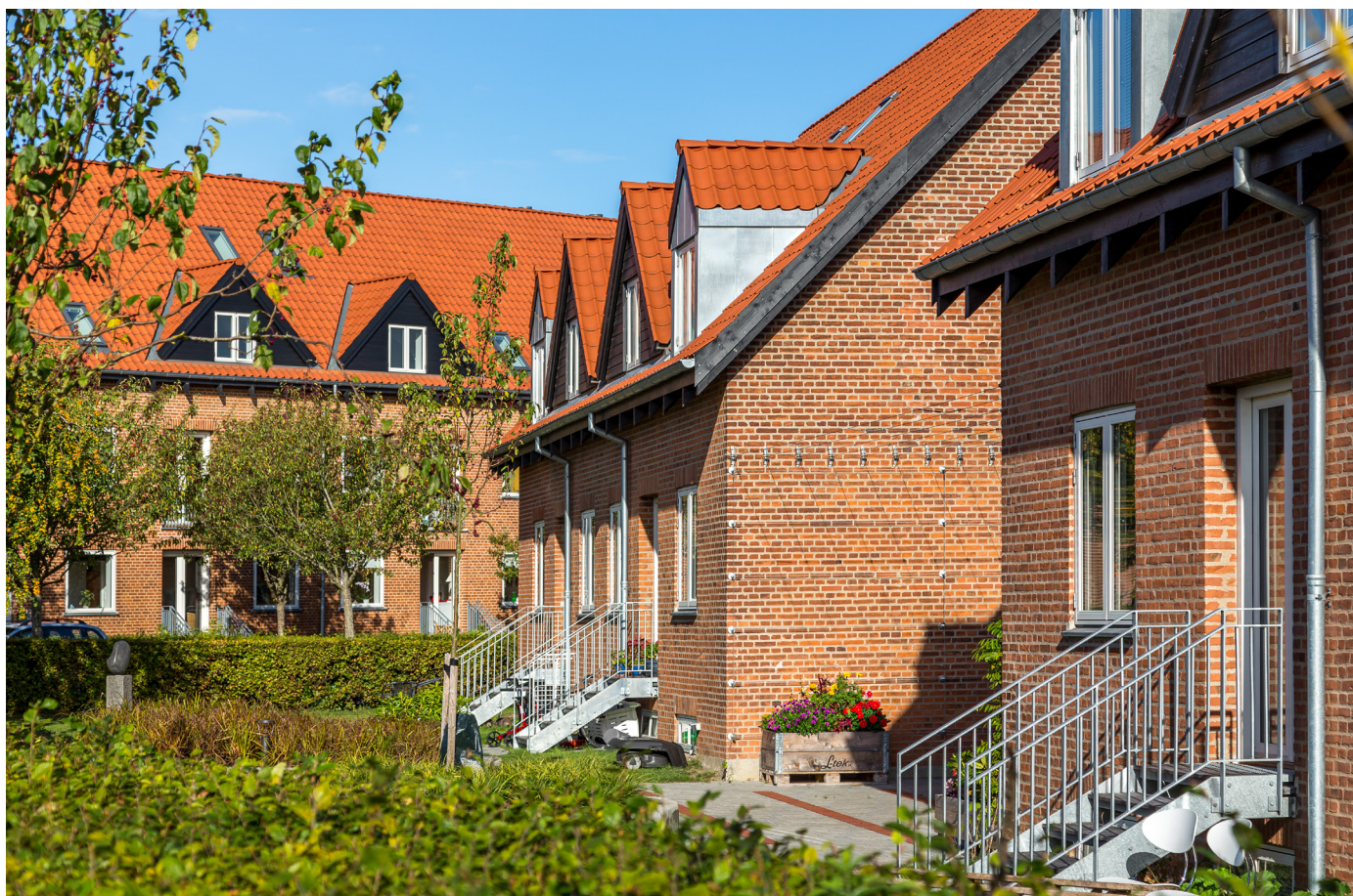
Dybbølvej efter renoveringen
