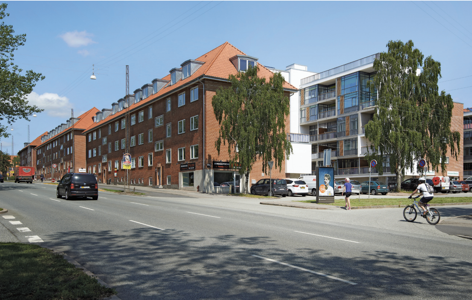
Tage Hansens Gade efter renoveringen
