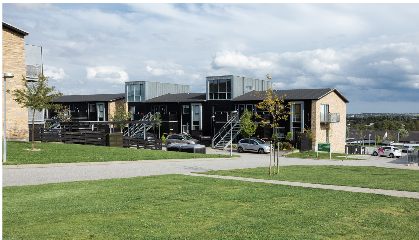
Sallingsundvej efter renoveringen
