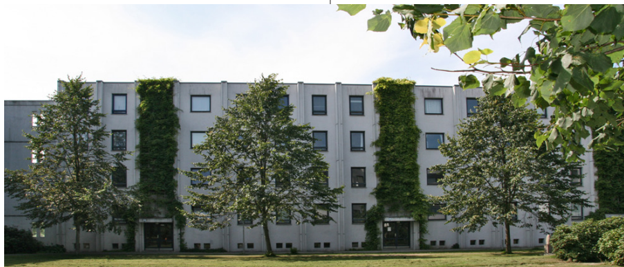
Rydevænget før renoveringen
