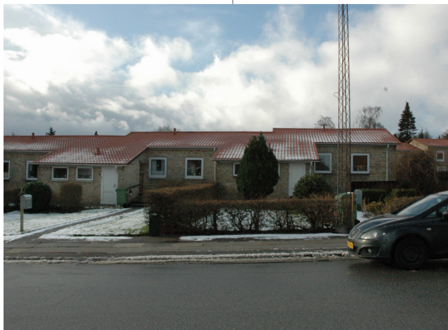
Møllevangen før renoveringen
