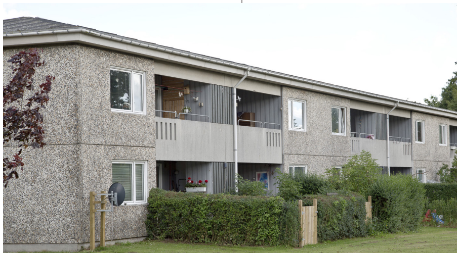
Fyrkildevej før renoveringen
