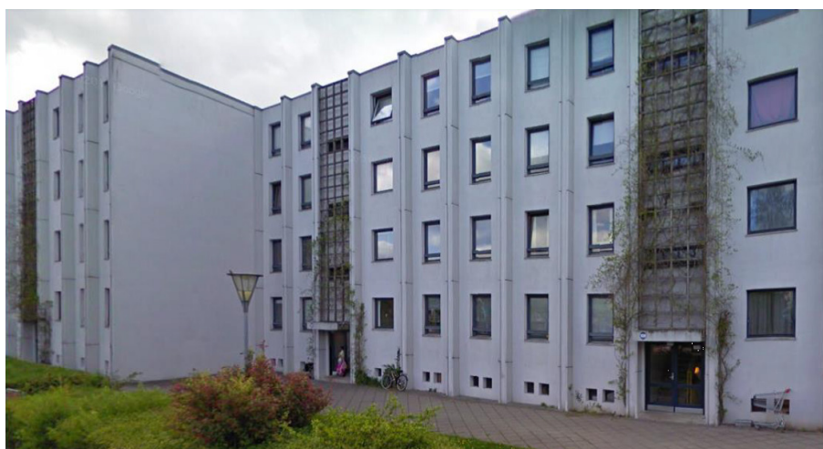
Rydevænget før renoveringen
