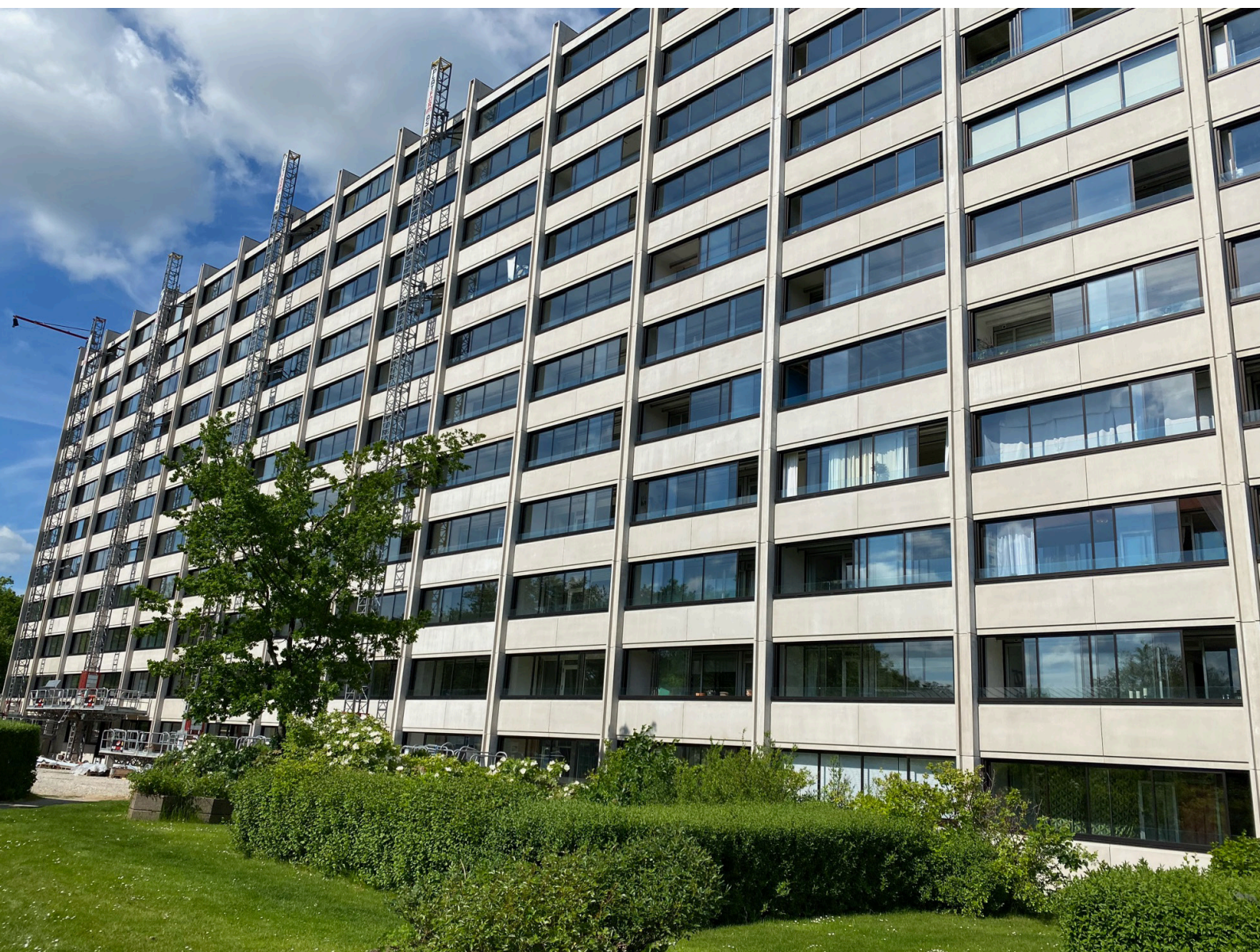
Klostervangen efter renoveringen
