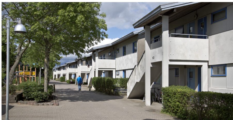
Sallingsundvej før renoveringen
